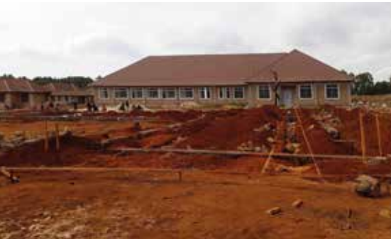
Das OP-Gebäude steht
