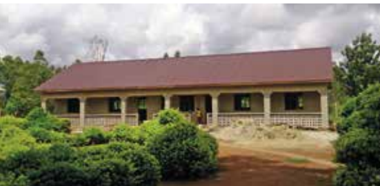
Der fertige Klassenraum
