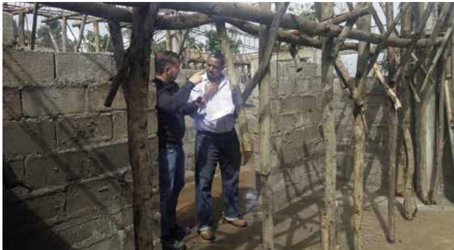
Heiko Sigg und Mr. Dirisa auf der Baustelle in Gari
